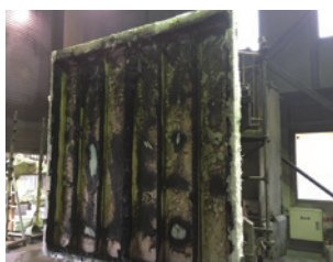
防火試験後(木外装:加熱面) 30分の防火試験後も柱が しっかり残っています。
